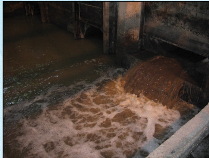
Vertido de alta carga en entrada de Planta
