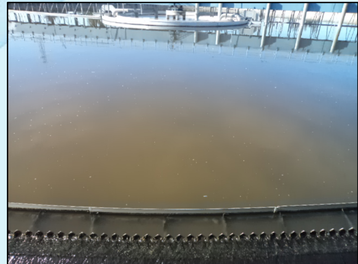
Vertido de alta carga en decantador primario
