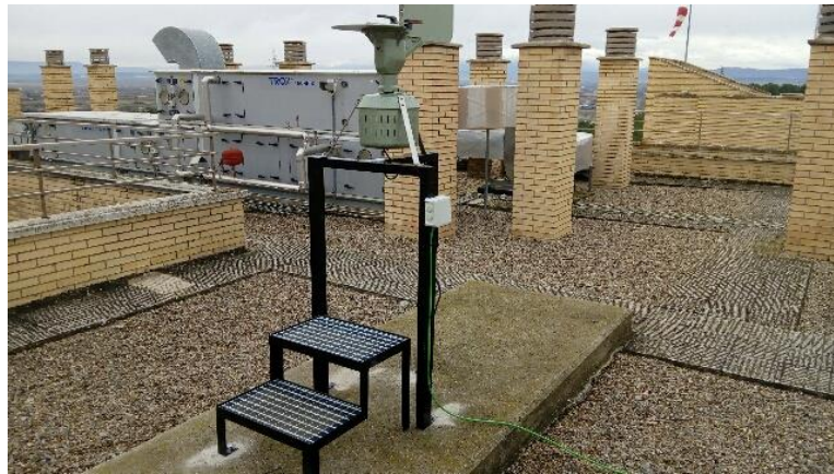
Azotea Hospital Reina Sofía Tudela
