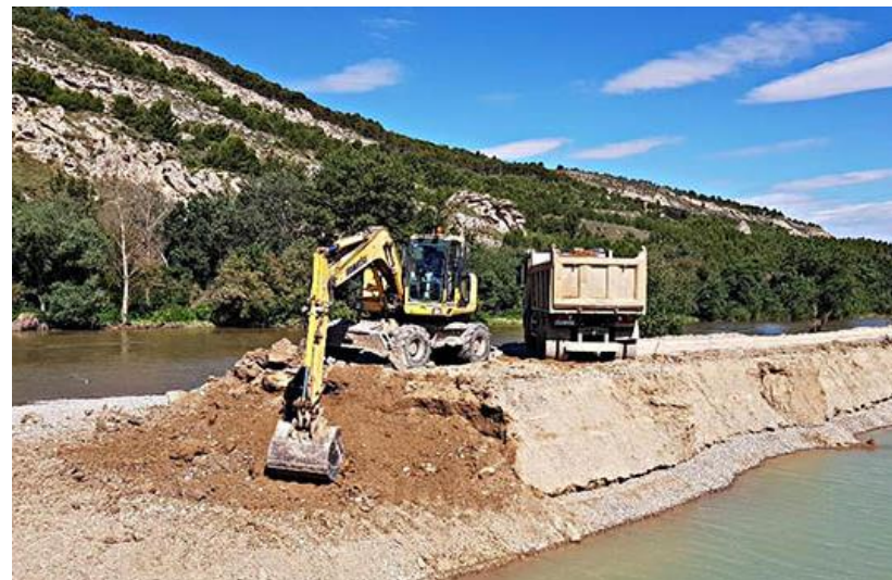
Eliminación de una antigua mota en el río Argá
