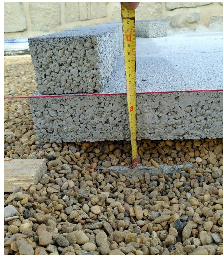
1. Pavimento Permeable (gravillín granítico lavado 5-12mm, en presto se puso grava lavada 3-6mm) Para el rejunteo – recebo gravillín de 2-4mm
