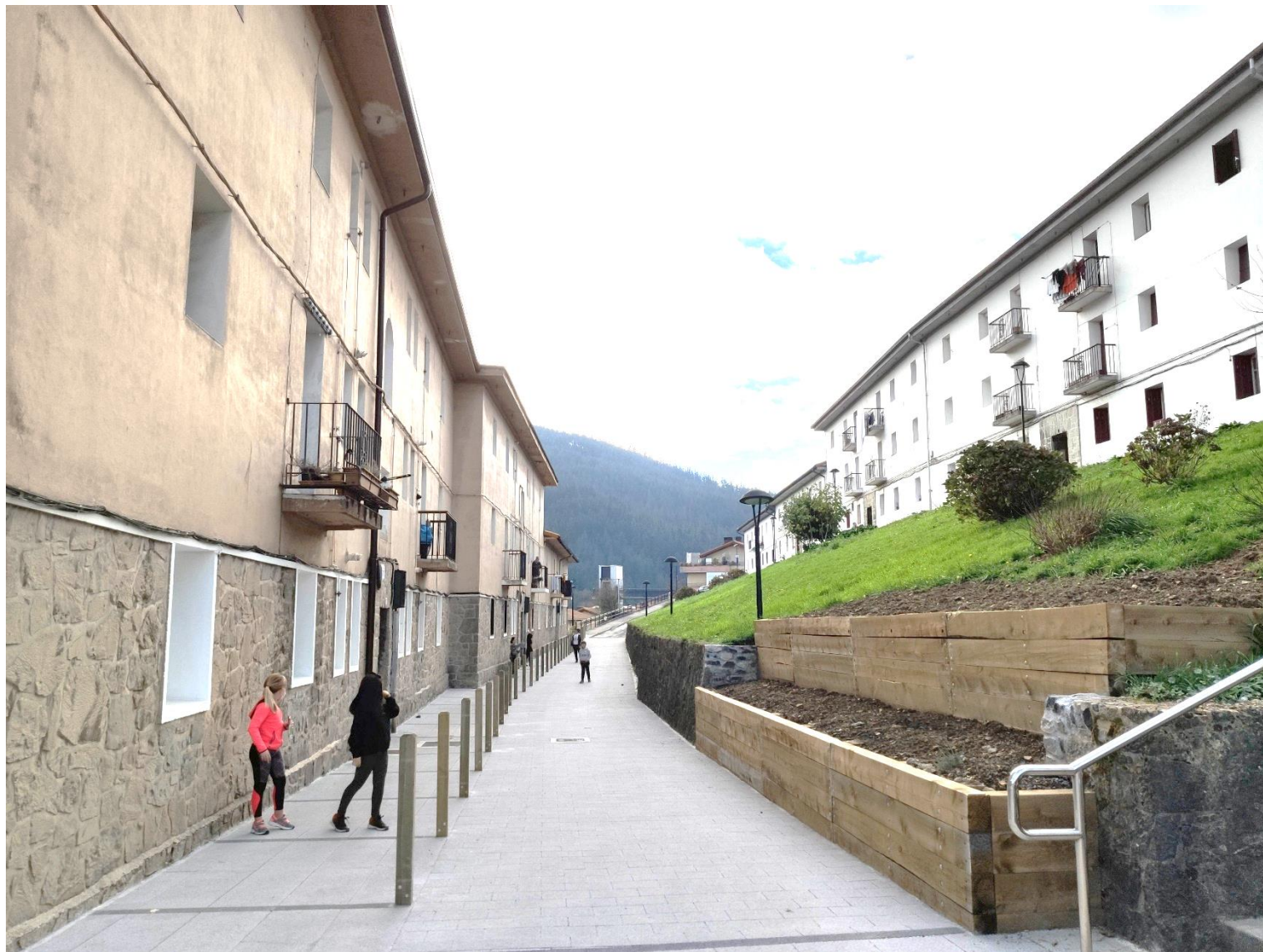
Muro contención + bolardos de madera
