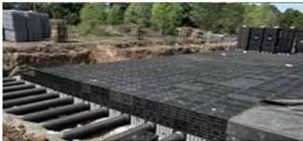
Depósitos de infiltración
