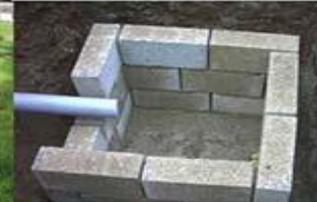
Pozo de infiltración
