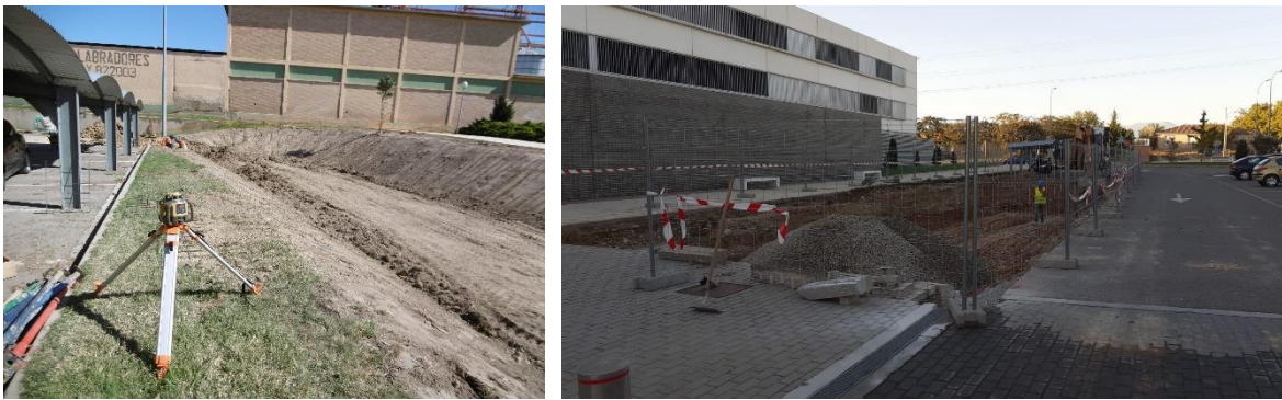
Figura 15 Construcción de los SUDS.
