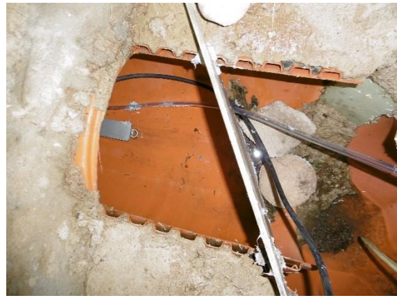
Figura 1 y Figura 2. Impedimento instalado para permitir la toma de muestras en el colector de pluviales
