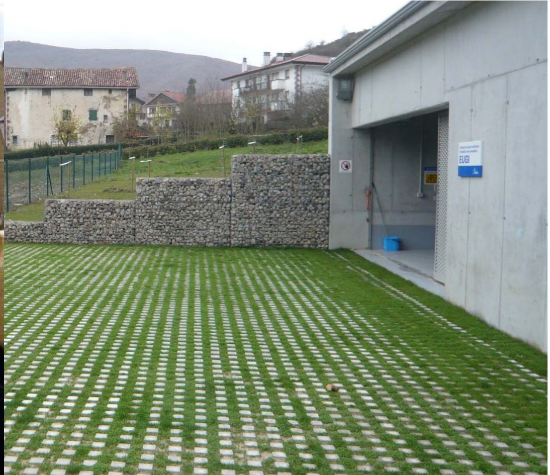
Pavimento permeable, estación bombeo agua residual Eugi. Nilsa
