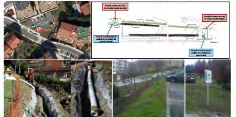
Dren poco profundo relleno de material filtrante y con recogida y transporte de agua en el fondo: 0,5x5x2m
