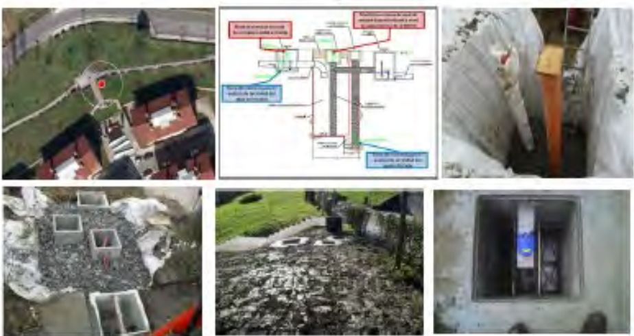
Superficie de infiltración vertical: d 1,5 x 3m
