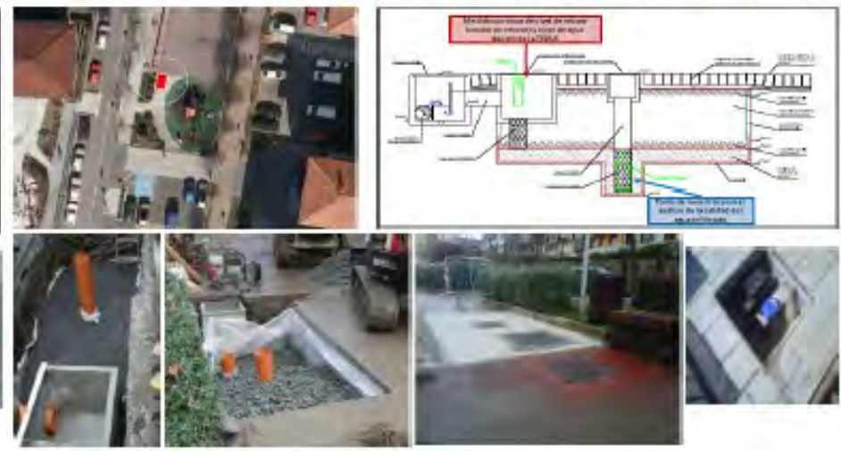
Dren poco profundo relleno de material filtrante y con recogida y transporte de agua en el fondo: 0,5x5x2m
